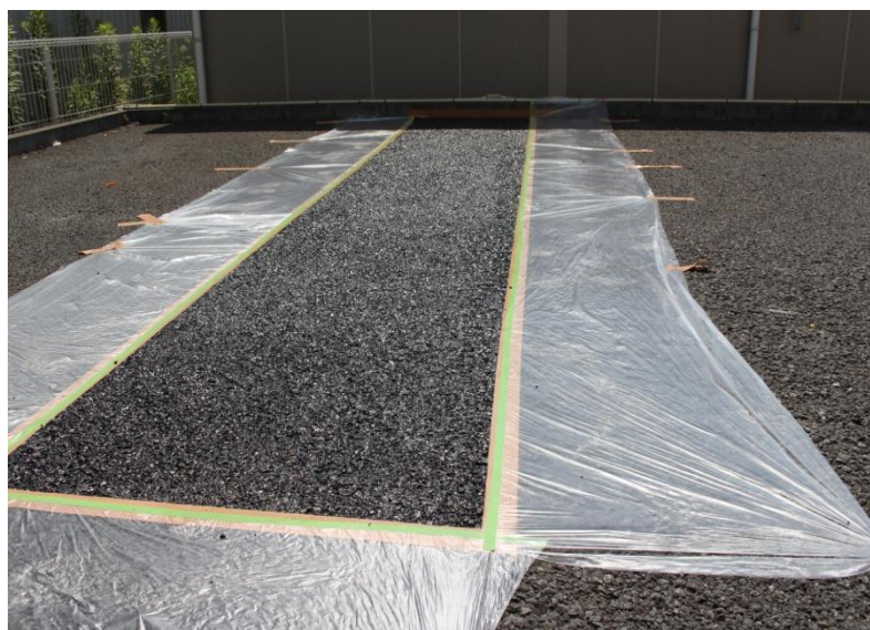
② プライマー 1回目塗布
