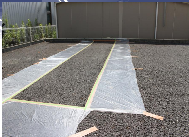
① 施工前全景
