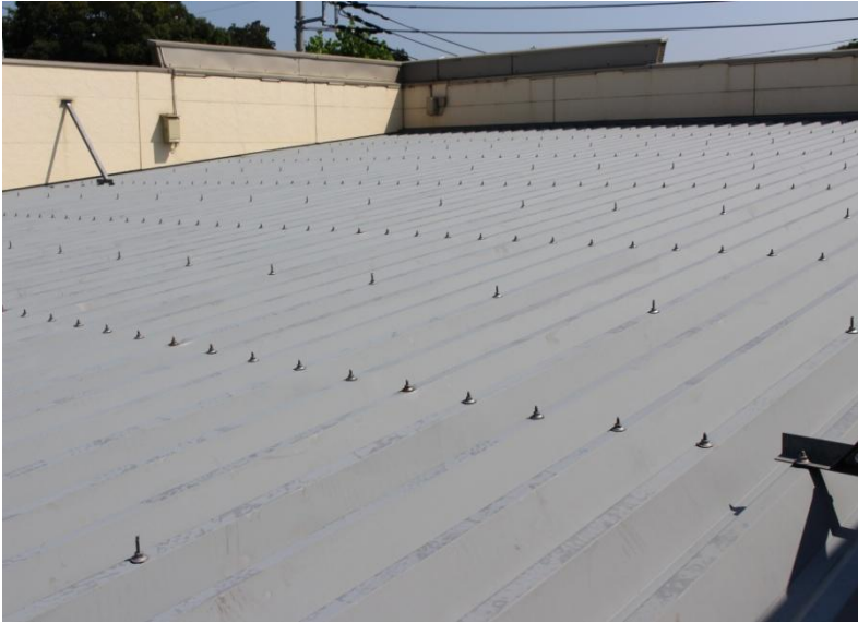
① 施工前全景
