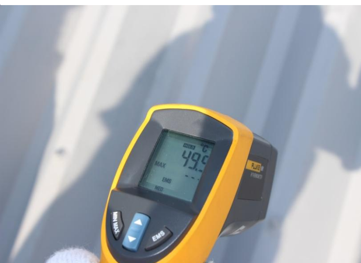
社屋屋根 施工後 49.5°C
