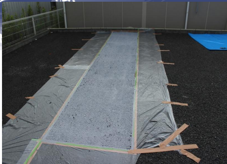
④熱交換塗料タフコート 1回目塗布
