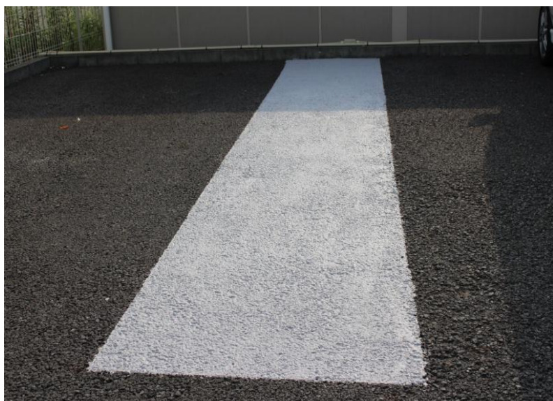
⑥熱交換塗料タフコート 3回目塗布
