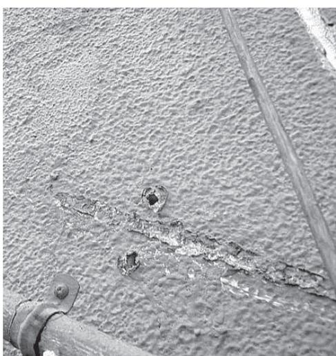
クラックやサッシ周りの傷みによって、壁体内への雨水侵入を招き、シロアリや木材腐朽菌が発生します。
